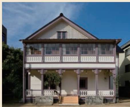
金沢市指定保存建造物 旧ウィン館
